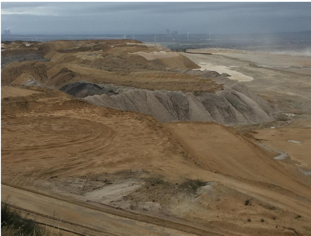
Abbildung 4: Massen der Innenkippen-Überhöhung Stand 2020; Blick nach Osten von höchster Kippkante am NO-Rand Tagebau Hambach, Höhenunterschied bis Geländeoberkante des Umlandes ca. 150 m, Verkippung hier fast ausschließlich tragfähiger Massen
